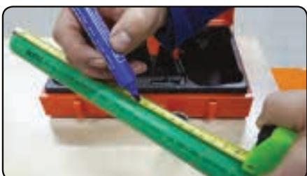
**2** Kesilmesi gereken uzunluğu ve kaynak derinliğini ölçün.
